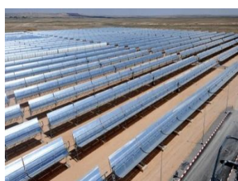
Energie solaire Complexe Noor Ouarzazate
