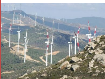
Energie éolienne Eolienne de Tanger
